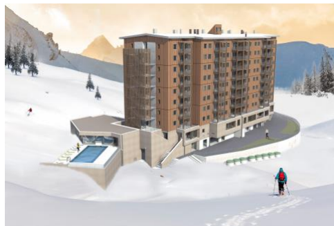
Vue d'ensemble du bâtiment.
